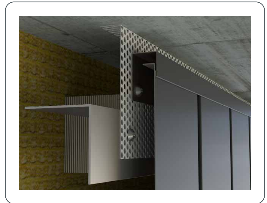
Figur 88 · Loddrett øvre ende av sidespor
