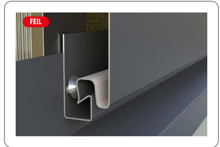
Figur 77 · Festestartprofil ikke OK
